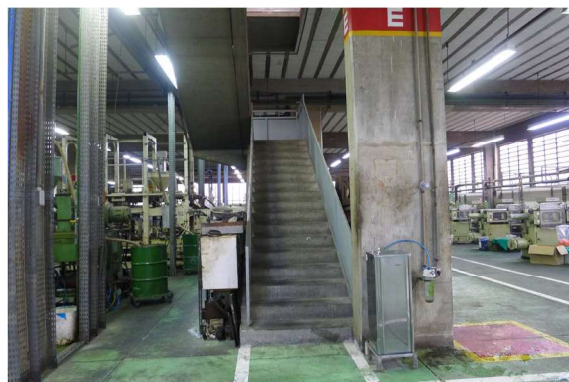
Instalações internas adequadas à operação industrial.
