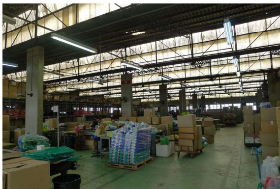
Áreas internas destacando cobertura em shield e docas de carreamento.
