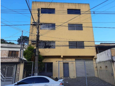
Representação Fachada Principal Descrição Data Foto 08/05/2021
